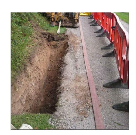
TYPICAL DRILLING RIG & LAUNCH PIT
